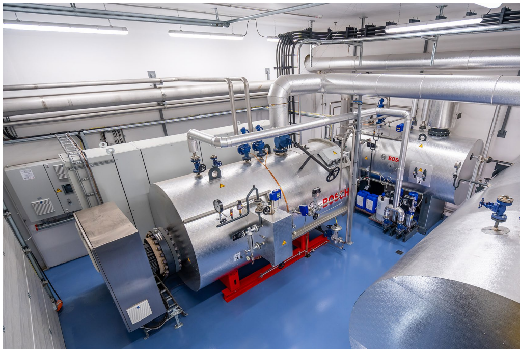
Bild_03: Elektrodampfkesselsystem von Bosch mit 100 Prozent Grünstromnutzung.
