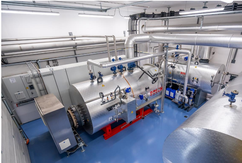
Bild_03: Elektrodampfkessel von Bosch mit Systemausstattung.
